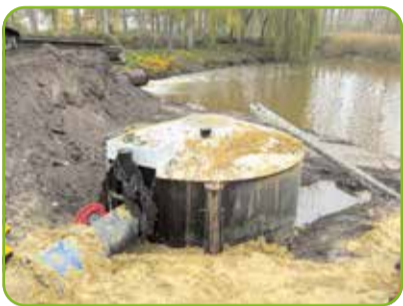
Foto 7: Smart vislift in aanbouw
