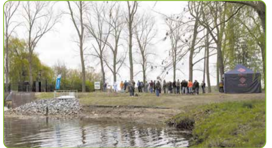
Foto 1: Officiële opening van de nieuwe stuw en smart vislift 10 april
