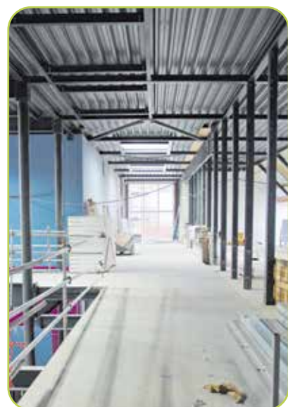
Doorloop eerste verdieping
