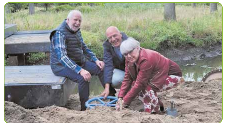
Vlnr: Peter Geboers, Vincent Lokin en Jetty Eugster zetten het omleiden van het water uit de Kleine Dommel in werking, zodat de werkzaamheden aan de stuw droog kunnen plaatsvinden
