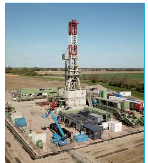
Tijdelijke onderzoeksboring in Heijningen
