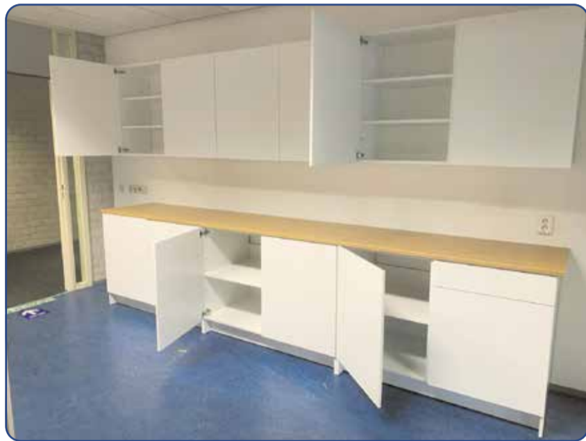
Door Senergie geplaatste keuken
