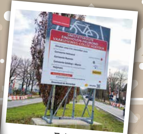
Week 5 AANLEG SNELFIETSPAD
