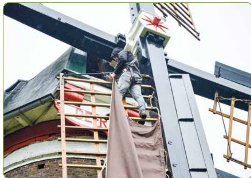
Jelle Koning (rechts) en Mario Collombon zetten het molenzeil vast op het hekwerk
