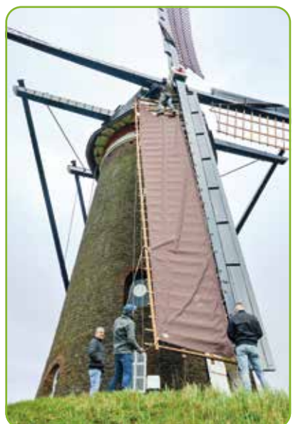
Jelle Koning (rechts) en Mario Collombon zetten het molenzeil vast op het hekwerk
