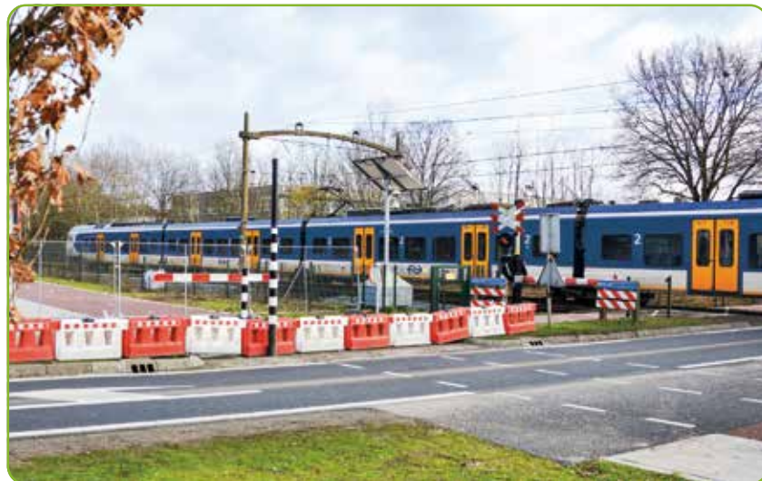
De afgesloten overstek van het snelfietspad bij de Collse Hoefdijk in Eeneind foto Cees van Keulen
