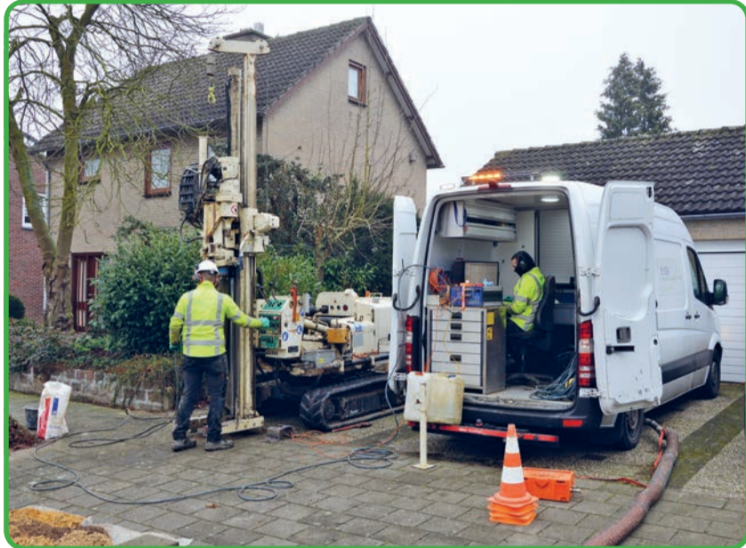
Met een sondeermachine wordt een diepe boring verricht aan de Mgr. Frenkenstraat in Gerwen (foto Cees van Keulen)
