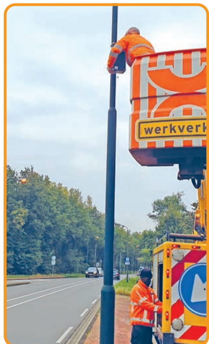
Plaatsing meetunit Geldropsedijk/ A270
