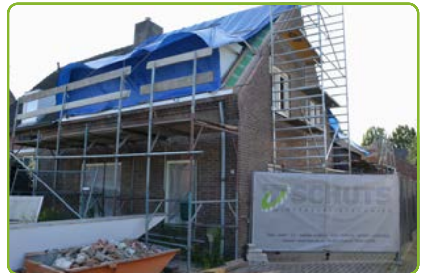
Renovatie van een woning aan de Ruitersweg in Gerwen.....
