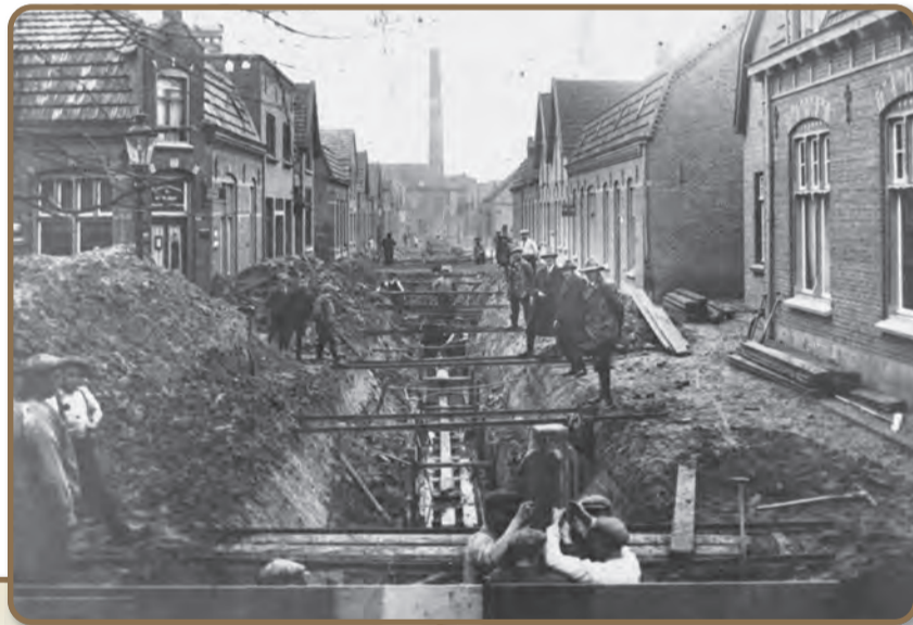
Aanleg van riolering in de St.-Severusstraat midden jaren dertig. (foto RHCE)
