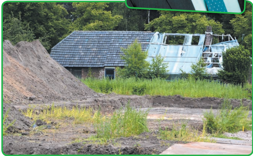
De grondwerkzaamheden in Gerwen ZO zijn gestart... (foto Cees van Keulen)
