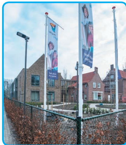
Het nieuwe woonzorgcentrum Savant van Lenthof in het centrum van Nueneen biedt dertig moderne appartementen met zorg voor mensen met dementie.
