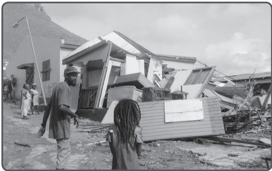
Mijn dochter die de schade bekijkt.
