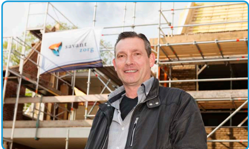
Bij de bouw staat Richard Dehne, coördinator van zorg voor het nieuwe woonzorgcentrum Savant van Lenthof. Het complex in de Kerkstraat is dit najaar gereed.
