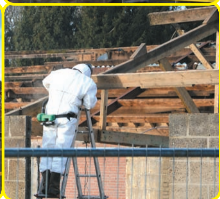
De aanwezige asbest wordt verwijderd uit de stallen bij boerderij Bunthof. Foto's Cees van Keulen
