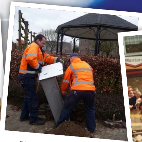
Plaatsen Terugbeelden Heemkundekring
