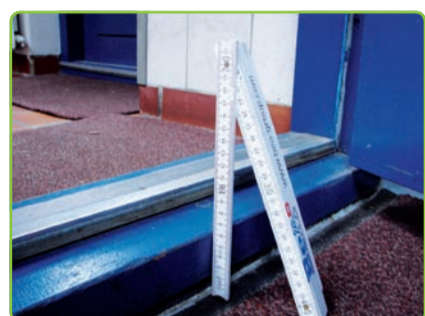
En 7 cm hoge drempel, een onneembare barrière voor rolstoelers en rollators zonder hulp!
