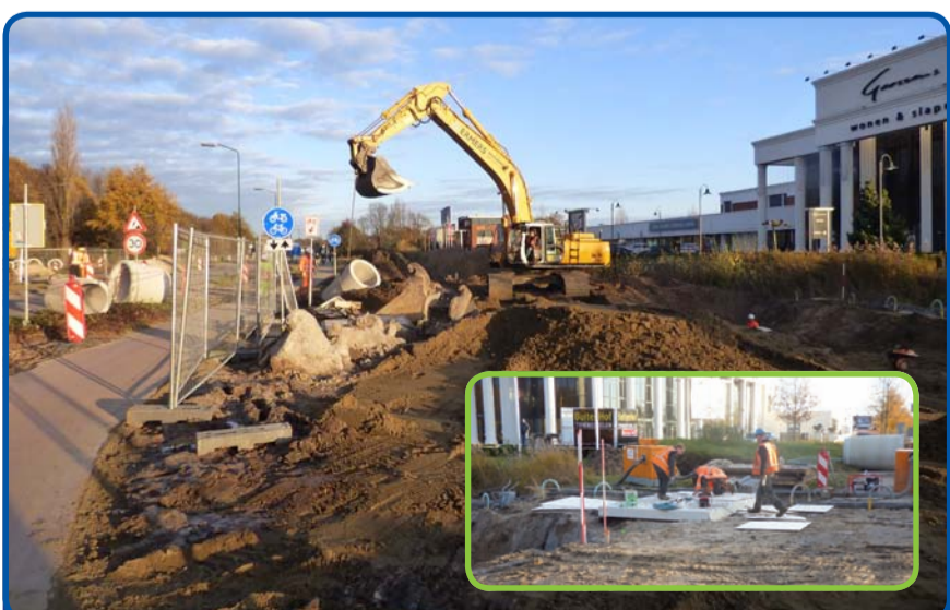
Er wordt flink aan de weg gewerkt bij de rotonde ter hoogte van 'Goossens wonen en slapen'. (Foto's Peter Coppens)
