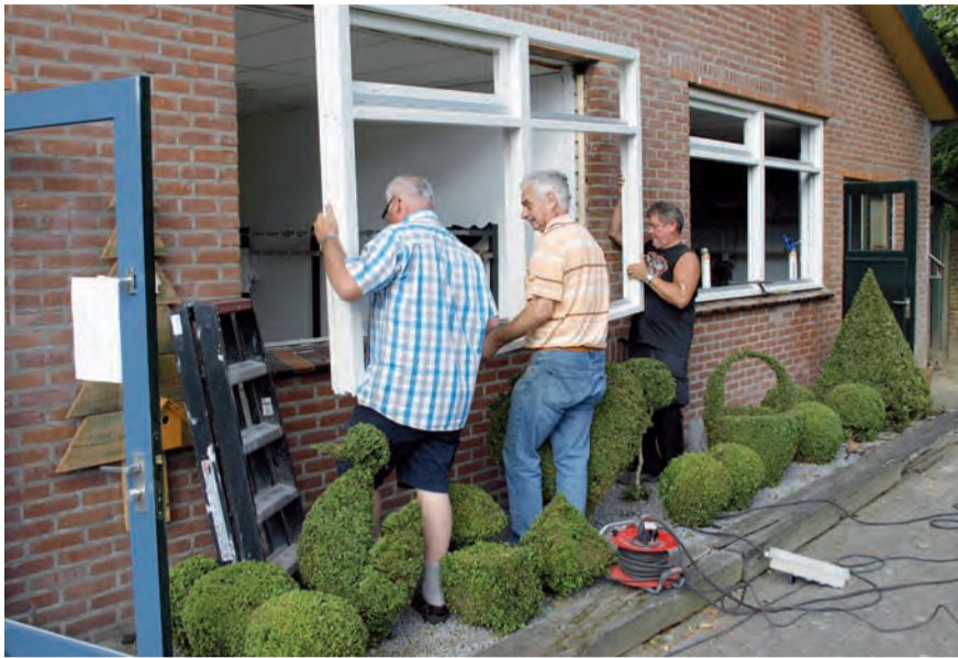
Dorpswerkplaats Nuenen vervangt 6 kozijnen.
