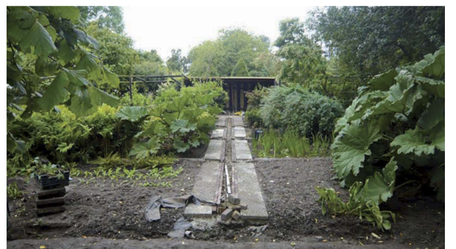
'Work in progress': de theatrale terrassentuin en het oude keetje in dit stadium van restauratie
