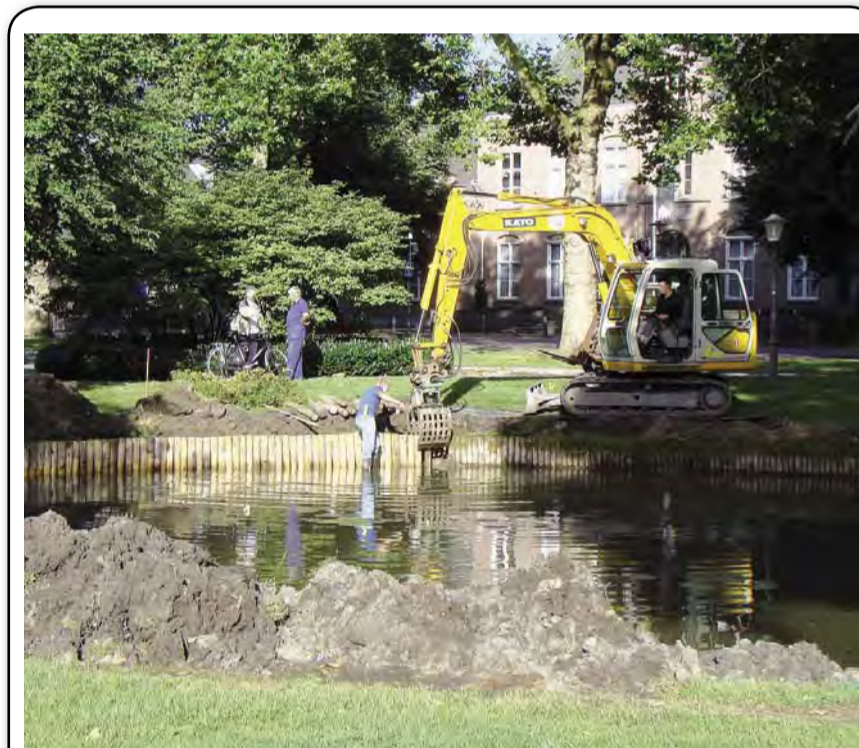
Onderhoudswerkzaamheden aan de Parkvijver: de zogenaamde beschoeiing, de houten palen van de omranding, worden vervangen.
