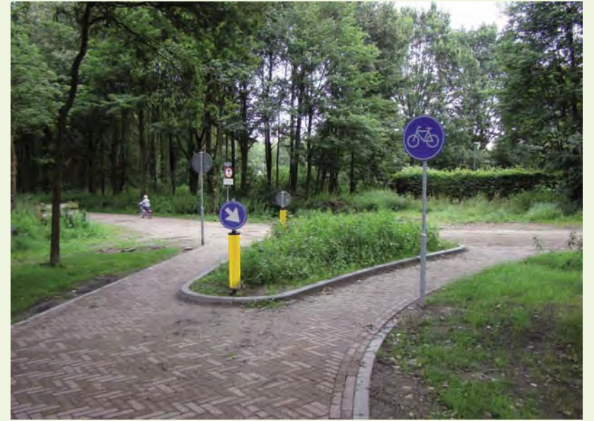
Nieuw in Nuenen: Als je vanuit de Lissevoort het Broek in gaat een verkeersplein speciaal voor fietsers. Met een overdaad aan verkeersborden.
