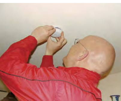
Burgemeester Houben installeert de eerste brandmelder in een woning aan de Hugo Brouwershof.
