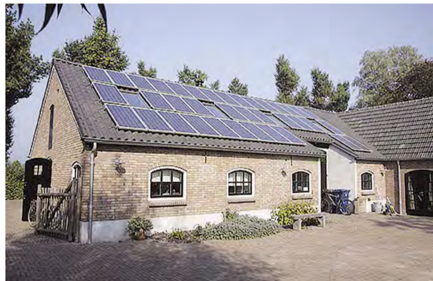
Zonnepanelen op het Boordhuys (Boord 37 te Nuenen)
